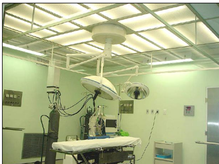
Figura 1 - Sala de Cirurgia com equipamentos do tipo Fan Filter com filtragem Absoluta. Fonte: Curso Sindratar - HVAC para Salas Limpas, Laboratórios e Áreas de Saúde.
