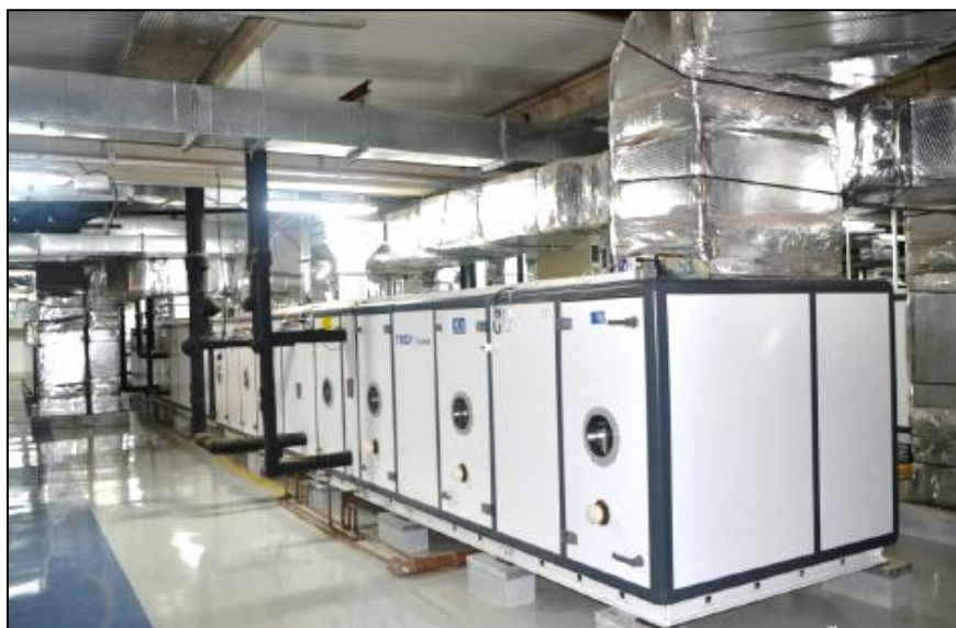
Figura 5 – Unidade de Tratamento de Ar típico de aplicação de processo, com diversos módulos para controle preciso dos parâmetros de projeto. Fonte: Curso Sindratar - HVAC para Salas Limpas, Laboratórios e Áreas de Saúde.
